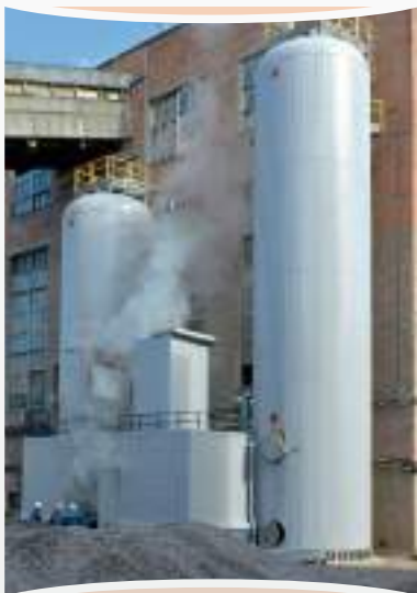
Рис. 3. Модернизация варочного цеха
